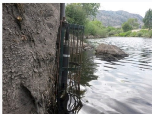
Sonda multiparamétrica en el río Tera casi totalmente emergida debido al nivel acusadamente bajo del río en el mes de agosto.
