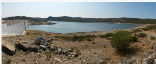
Embalse de Puente Porto con niveles bajos de agua almacenada a finales del verano.
